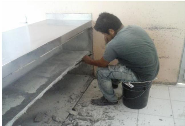
RECORTE Y EMBOQUILLADO DE ENTREPAÑOS DE CONCRETO ARMADO EN COCINA EN PROCESO
