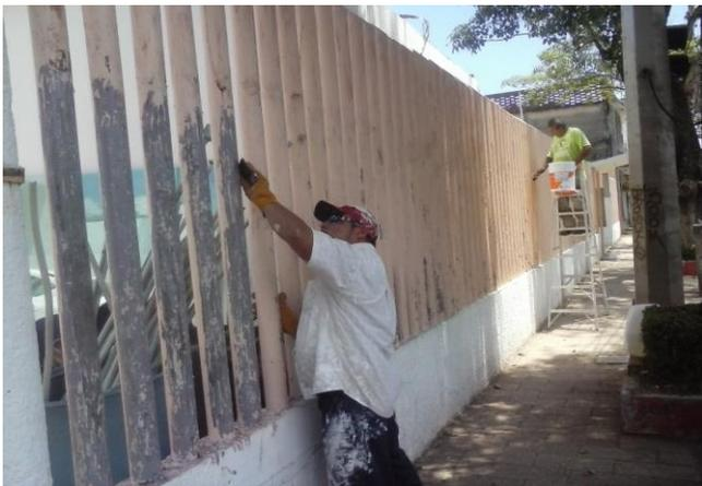
APLICACION DE PINTURA DE ESMALTE (PROCESO DE LIMPIEZA CON REMOVEDOR)
