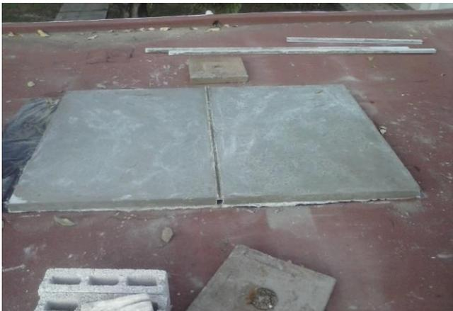
FABRICACION DE BASES DE CONCRETO ARMADO PARA TINACOS EN AZOTEA FINAL
