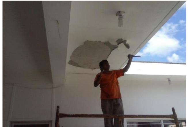
RECORTE , PICADO Y REPELLADO DE PLAFON DETERIORADO EN AREA DE FILTRO. EN PROCESO
