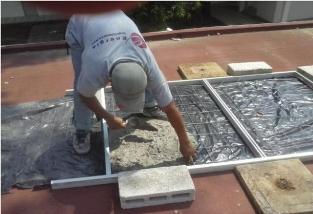
FABRICACION DE BASES DE CONCRETO ARMADO PARA TINACOS EN AZOTEA EN PROCESO
