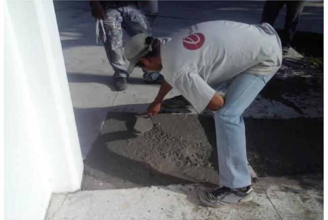
FABRICACION DE RAMPA DE CONCRETO ARMADO EN PASILLO FINAL
