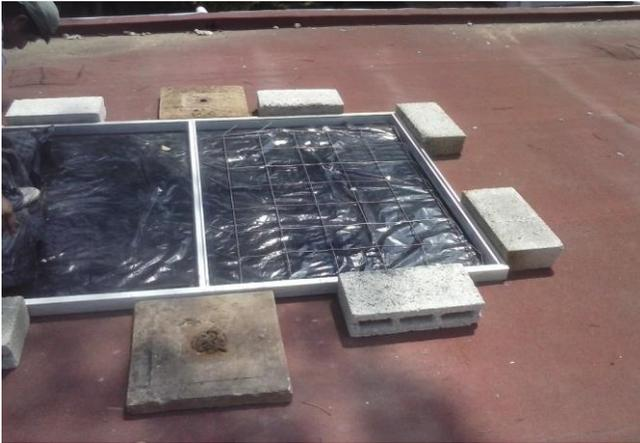
FABRICACION DE BASES DE CONCRETO ARMADO PARA TINACOS EN AZOTEA ANTES
