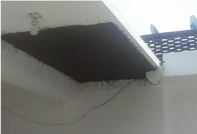
RECORTE , PICADO Y REPELLADO DE PLAFON DETERIORADO EN AREA DE FILTRO. FINAL
