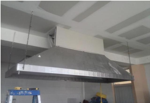
FABRICACION DE ENVOLVENTE DE TABLAROCA EN CAMPANA DE EXTRACCION EN PROCESO
