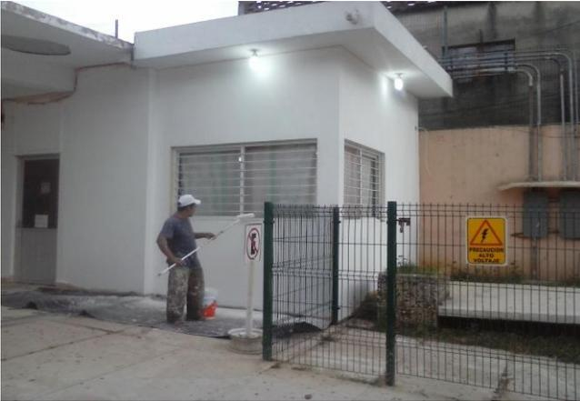
RECORTE , PICADO Y REPELLADO DE PLAFON DETERIORADO EN AREA DE FILTRO. ANTES
