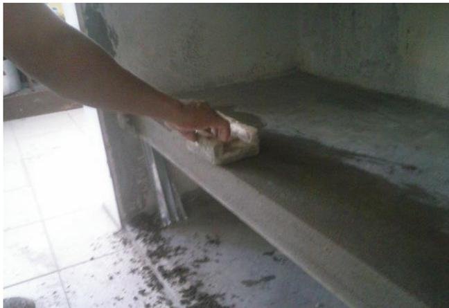
RECORTE Y EMBOQUILLADO DE ENTREPAÑOS DE CONCRETO ARMADO EN COCINA FINAL
