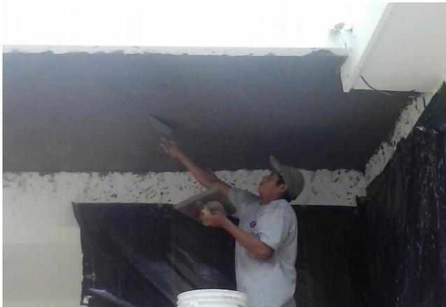
RECORTE , PICADO Y REPELLADO DE PLAFON DETERIORADO EN AREA DE FILTRO. EN PROCESO
