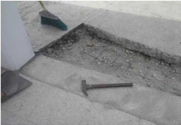
FABRICACION DE RAMPA DE CONCRETO ARMADO EN PASILLO EN PROCESO
