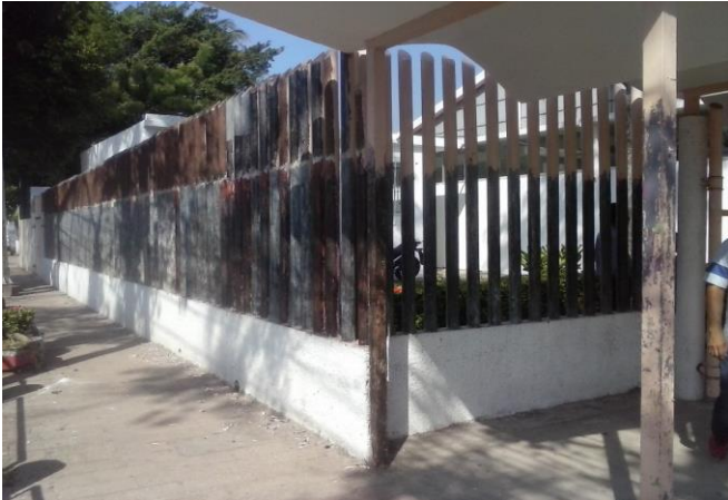
APLICACIÓN DE PINTURA DE ESMALTE EN HERRERÍA EN FACHADA PRINCIPAL EN PROCESO
