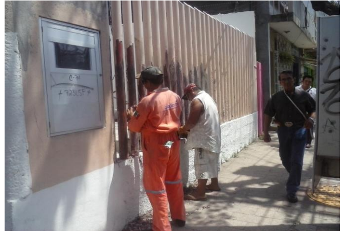
APLICACIÓN DE PINTURA DE ESMALTE EN HERRERÍA EN FACHADA PRINCIPAL EN PROCESO
