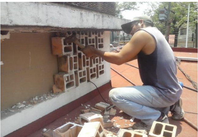
DEMOLICION DE CELOSIA DE BARRO EXTRUIDO EN ILUMINACION CENITAL EN DIRECCION EN PROCESO
