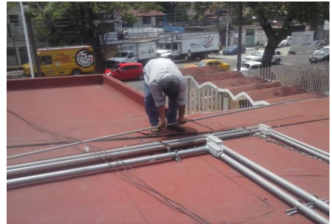
TENDIDO DE TUBERIA CONDULET DE 1 1/2" EN AZOTEA PARA ALIMENTACION DE TABLERO EN CENTRO DE COMPUTO EN PROCESO
