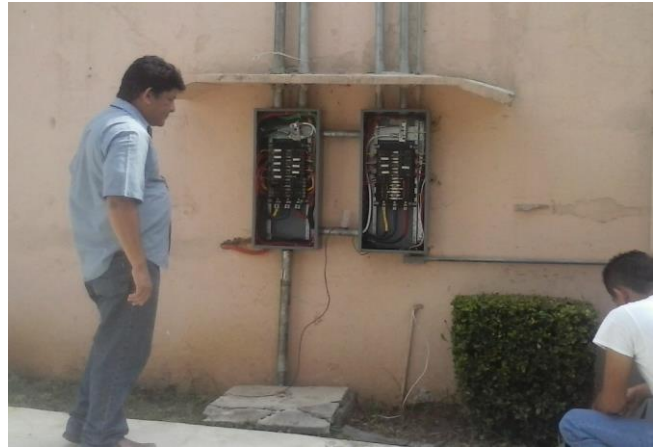
IDENTIFICACION Y MARCADO DE CIRCUITOS EN AREA DE CASETA ANTES
