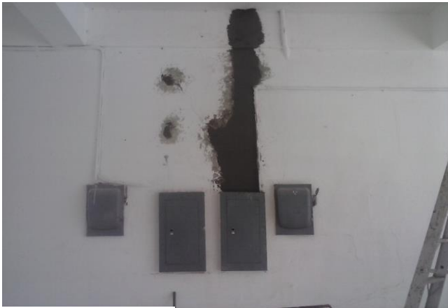
RANURADO EN MURO Y LOSA PARA ALIMENTACION DE TABLEROS "C" Y "D" EN AREA DE FILTRO FINAL
