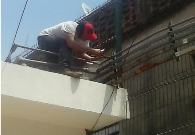
TENDIDO DE TUBERIA CONDULET DE 1 1/2" EN AZOTEA PARA ALIMENTACION DE TABLERO EN CENTRO DE COMPUTO INICIO
