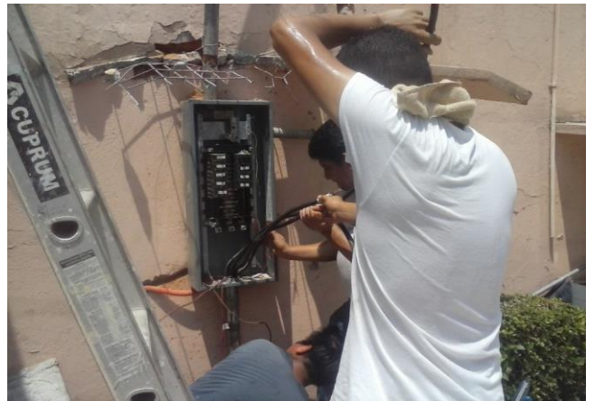
DESMANTELAMIENTO DE TABLEROS TRIFASICOS "A" Y "B" EN AREA DE CASETA DE ALTA TENSION EN PROCESO
