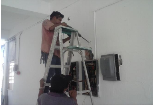
RANURADO EN MURO Y LOSA PARA ALIMENTACION DE TABLEROS "C" Y "D" EN AREA DE FILTRO INICIO
