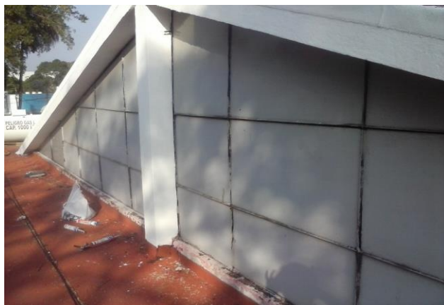
SELLADO DE VENTANAS DE HERRERIA EN PARTE SUPERIOR DE COMEDOR FINAL
