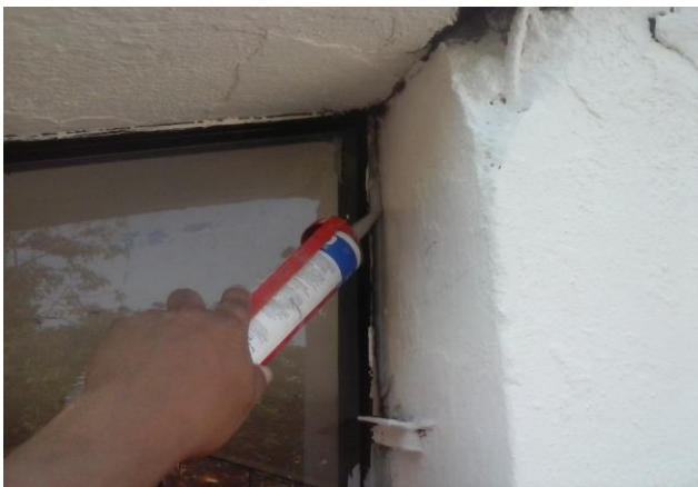
SELLADO DE VENTANAS DE HERRERIA EN PARTE SUPERIOR DE COMEDOR INICIO
