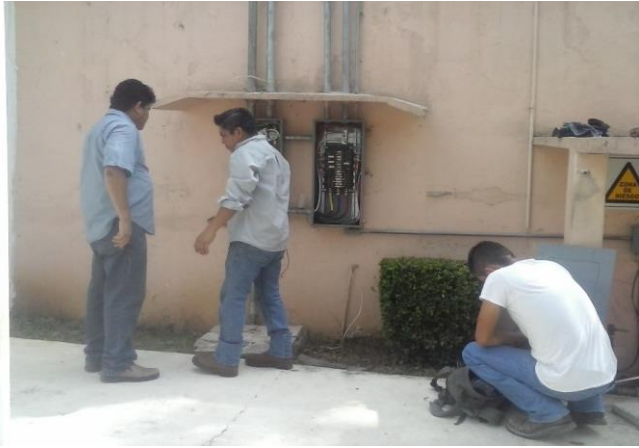
IDENTIFICACION Y MARCADO DE CIRCUITOS EN AREA DE CASETA ANTES
