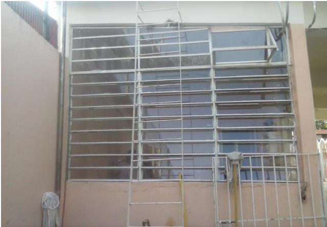
DESMANTELAMIENTO DE HERRERIA TROPICAL AREA DE TRABAJO SOCIAL Y CONSULTORIO MEDICO ANTES
