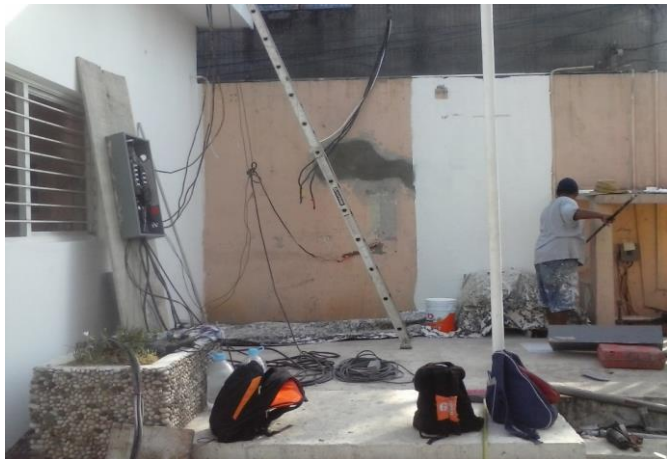
APLICACIÓN DE PINTURA VINILICA EN DIVERSAS AREAS EN PROCESO
