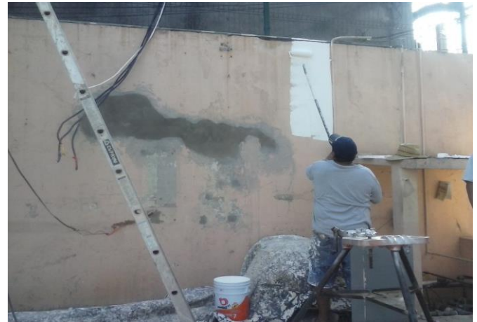
APLICACIÓN DE PINTURA VINILICA EN DIVERSAS AREAS EN PROCESO
