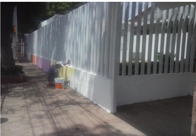
APLICACIÓN DE PINTURA DE ESMALTE EN HERRERÍA EN FACHADA PRINCIPAL FINAL
