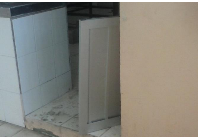
COLOCACION DE LOSETA ESMALTADA COLOR BLANCO EN DIVERSAS AREAS FINAL
