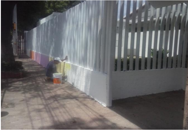
APLICACIÓN DE PINTURA VINILICA EN COLORES EN BARDA DE FACHADA PRINCIPAL INICIO
