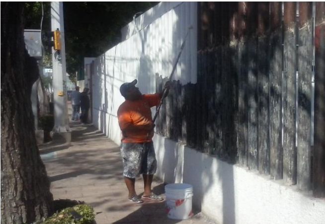
APLICACIÓN DE PINTURA DE ESMALTE EN HERRERÍA EN FACHADA PRINCIPAL EN PROCESO
