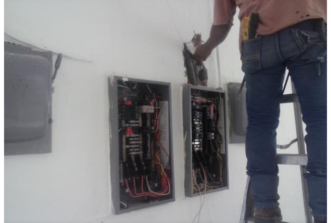
RANURADO EN MURO Y LOSA PARA ALIMENTACION DE TABLEROS "C" Y "D" EN AREA DE FILTRO EN P'ROCESO
