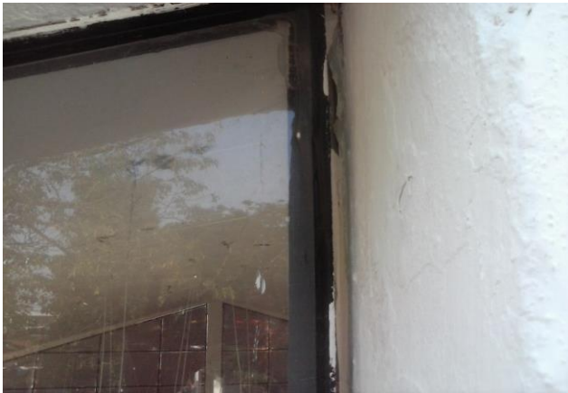
SELLADO DE VENTANAS DE HERRERIA EN PARTE SUPERIOR DE COMEDOR ANTES
