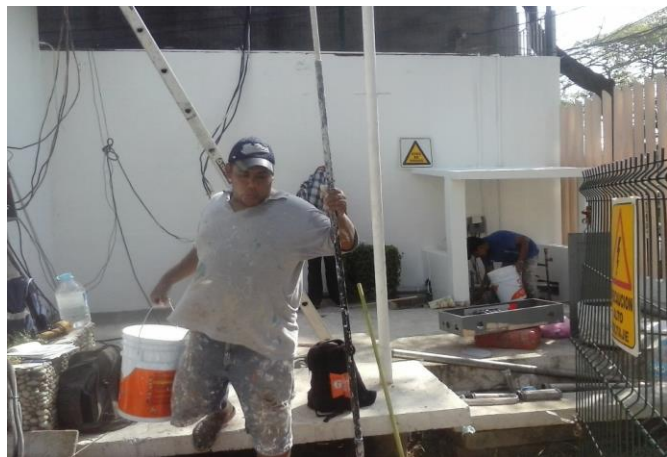
APLICACIÓN DE PINTURA VINILICA EN DIVERSAS AREAS FINAL
