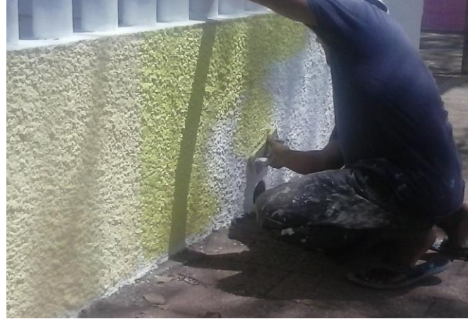
APLICACIÓN DE PINTURA VINILICA EN COLORES EN BARDA DE FACHADA PRINCIPAL INICIO
