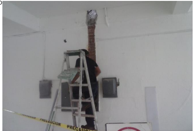
RANURADO EN MURO Y LOSA PARA ALIMENTACION DE TABLEROS "C" Y "D" EN AREA DE FILTRO EN P'ROCESO
