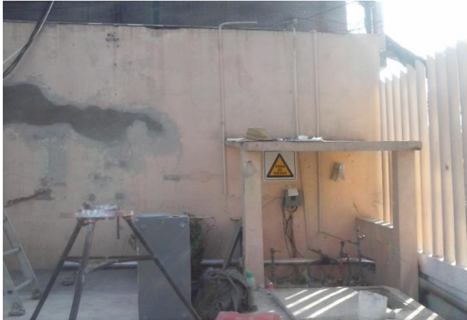
APLICACIÓN DE PINTURA VINILICA EN DIVERSAS AREAS ANTES
