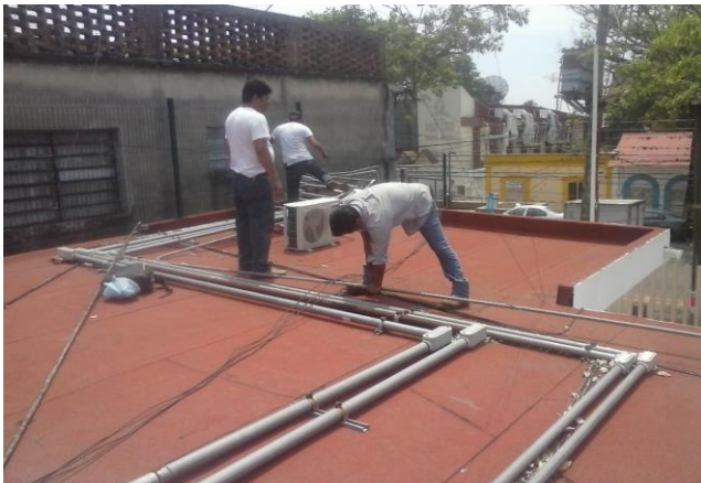
TENDIDO DE TUBERIA CONDULET DE 1 1/2" EN AZOTEA PARA ALIMENTACION DE TABLERO EN CENTRO DE COMPUTO EN PROCESO
