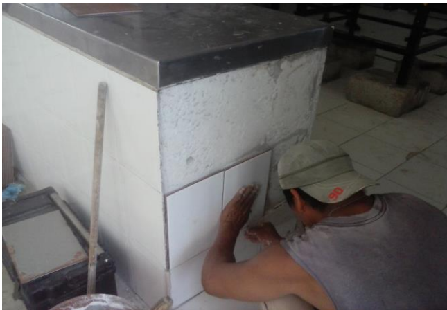
COLOCACION DE LOSETA ESMALTADA COLOR BLANCO EN DIVERSAS AREAS EN PROCESO
