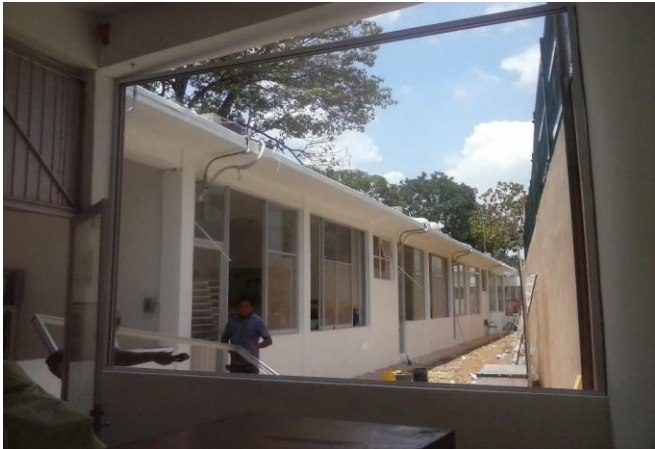
FABRICACION DE VENTANAS DE CANCELERIA DE ALUMINIO EN AREAS DE CONSULTORIO MEDICO Y TRABAJO SOCIAL INICIO
