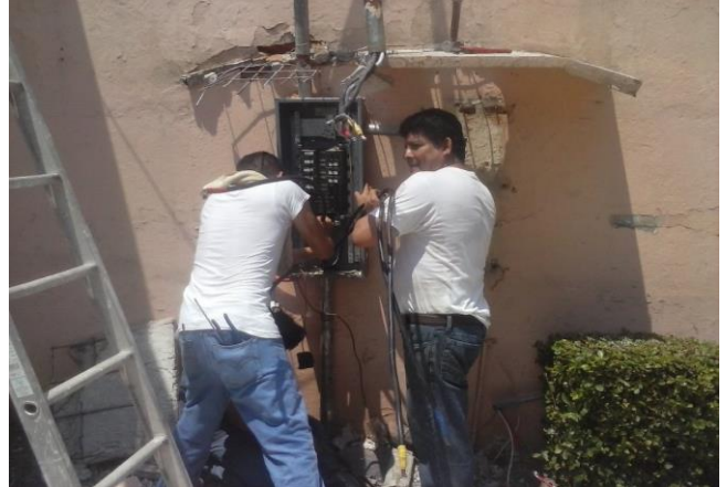
DESMANTELAMIENTO DE TABLEROS TRIFASICOS "A" Y "B" EN AREA DE CASETA DE ALTA TENSION EN PROCESO
