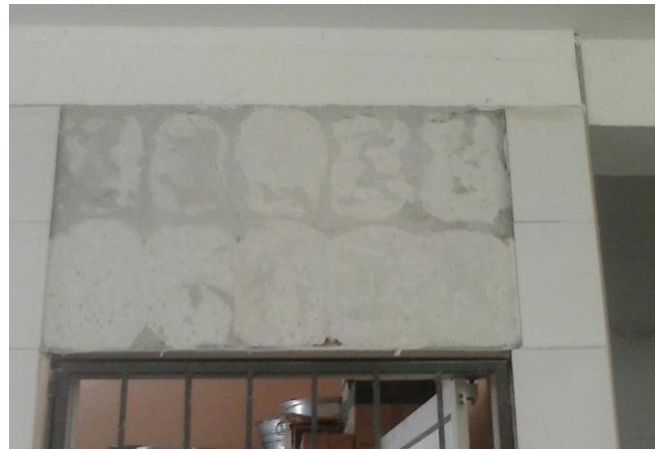
COLOCACION DE LOSETA ESMALTADA COLOR BLANCO EN DIVERSAS AREAS ANTES
