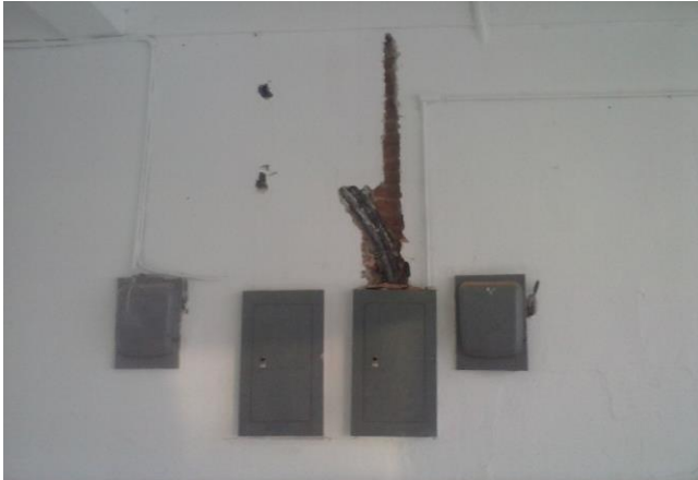
RANURADO EN MURO Y LOSA PARA ALIMENTACION DE TABLEROS "C" Y "D" EN AREA DE FILTRO EN P'ROCESO
