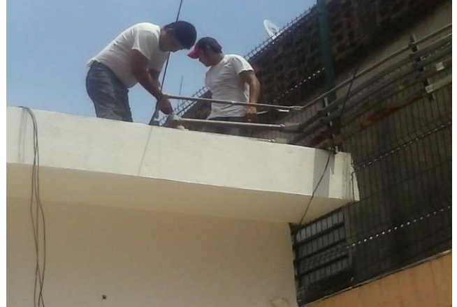
TENDIDO DE TUBERIA CONDULET DE 1 1/2" EN AZOTEA PARA ALIMENTACION DE TABLERO EN CENTRO DE COMPUTO INICIO
