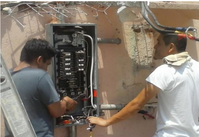
DESMANTELAMIENTO DE TABLEROS TRIFASICOS "A" Y "B" EN AREA DE CASETA DE ALTA TENSION EN PROCESO
