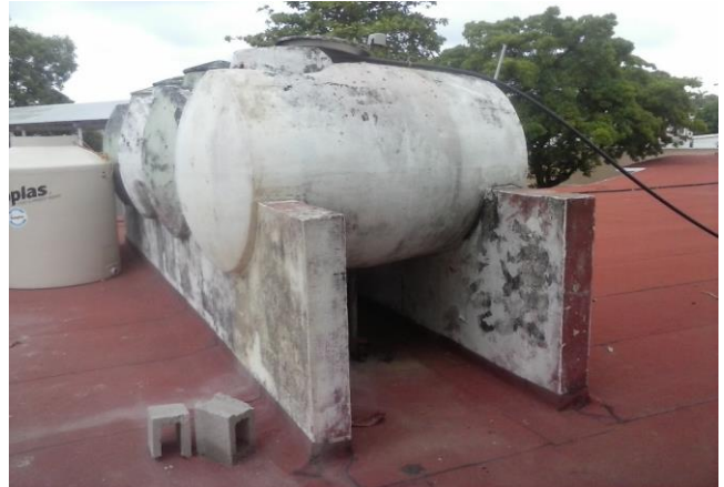
DEMOLICION DE TINACOS DE ASBESTO. EN AREA DE AZOTEA EN PROCESO
