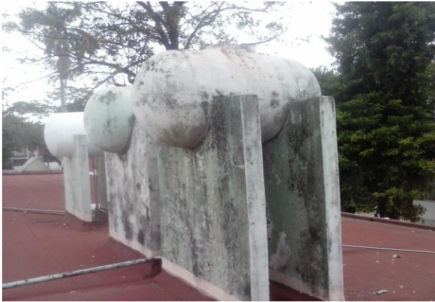
DEMOLICION DE TINACOS DE ASBESTO. EN AREA DE AZOTEA ANTES
