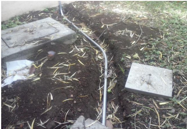
ENCOFRADO DE TUBERIA CONDUIT GALVANIZADO EN AREAS EXTERIORES EN PROCESO
