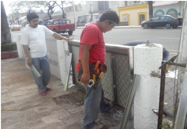
FABRICACION DE TABLEROS DE DUROCK A DOS CARAS EN FACHADA PRINCIPAL EN PROCESO
