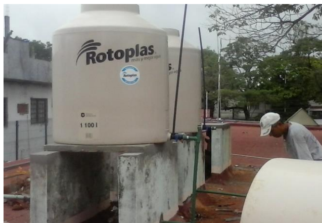
INST. DE TINACOS ROTOPLAS TRICAPA DE 1100 LTS. AREA DE AZOTEA FINAL
