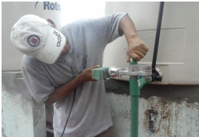
INST. DE TINACOS ROTOPLAS TRICAPA DE 1100 LTS. AREA DE AZOTEA EN PROCESO
