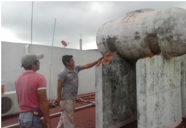
DEMOLICION DE TINACOS DE ASBESTO. EN AREA DE AZOTEA EN PROCESO
