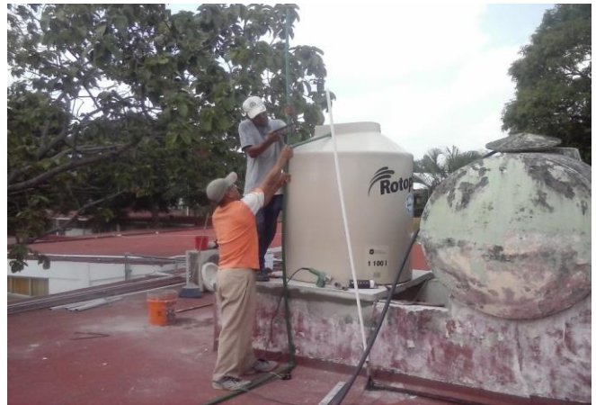
SUSTITUCION DE MANGUERA DE 19 MM POR TUBO PLUS EN ALIMENTACION HIDRAULICA DE TINACOS FINAL
