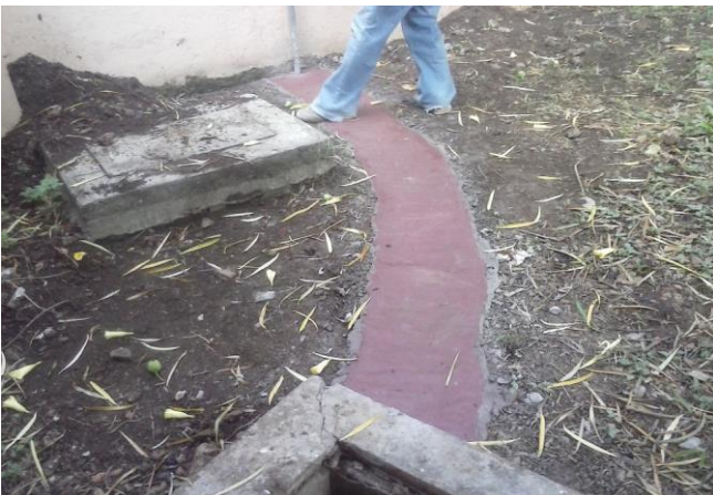
DEMOLICION DE CELOSIA DE BARRO EXTRUIDO EN ILUMINACION CENITAL EN DIRECCION FINAL
