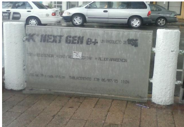
FABRICACION DE TABLEROS DE DUROCK A DOS CARAS EN FACHADA PRINCIPAL FINAL
