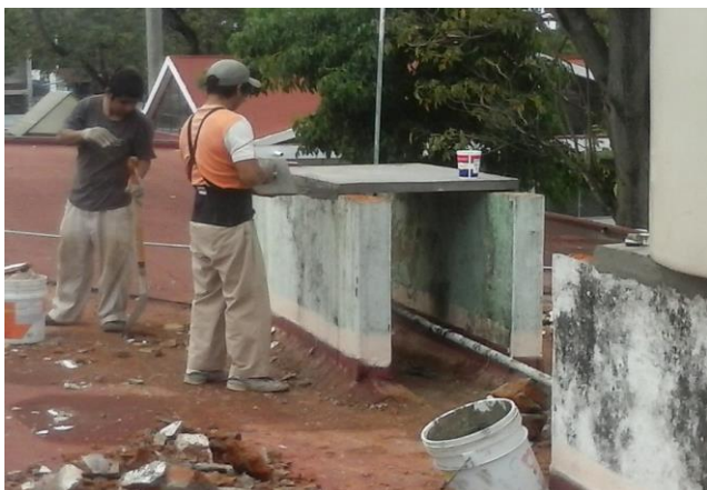
DEMOLICION DE TINACOS DE ASBESTO Y COLOCCION DE TINACOS ROTOPLAS TRICAPA DE 1100 LTS. EN AREA DE AZOTEA FINAL
