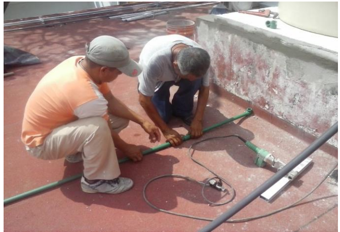
SUSTITUCION DE MANGUERA DE 19 MM EN ALIMENTACION HIDRAULICA DE TINACOS EN PROCESO
