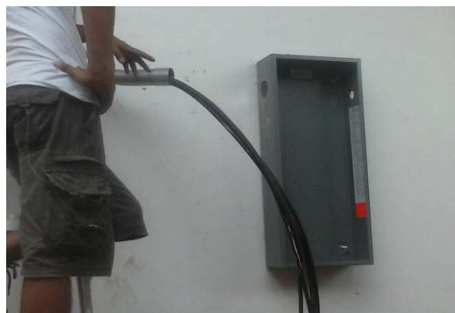
ALIMENTACION ELECTRICA A TABLERO "C" EN AREA DE FILTRO EN PROCESO
