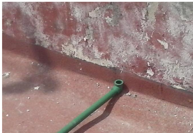
SUSTITUCION DE MANGUERA DE 19 MM POR TUBO PLUS EN ALIMENTACION HIDRAULICA DE TINACOS FINAL
