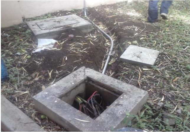
ENCOFRADO DE TUBERIA CONDUIT GALVANIZADO EN AREAS EXTERIORES INICIO
