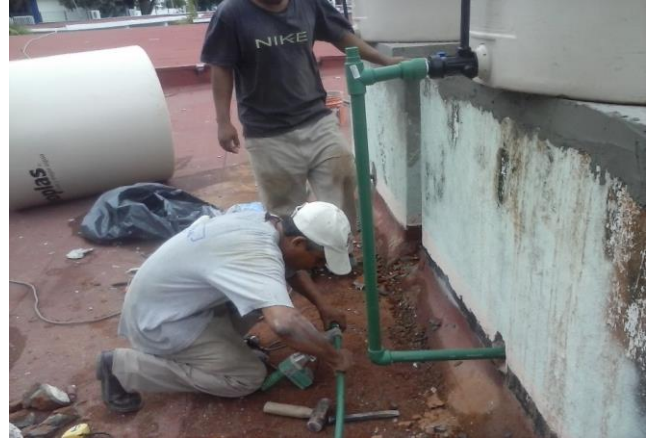
INST. DE TINACOS ROTOPLAS TRICAPA DE 1100 LTS. AREA DE AZOTEA ANTES
