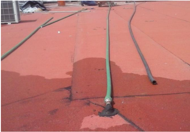
SUSTITUCION DE MANGUERA DE 19 MM POR TUBO PLUS EN ALIMENTACION HIDRAULICA DE TINACOS INICIO
