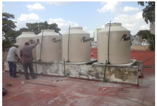
INST. DE TINACOS ROTOPLAS TRICAPA DE 1100 LTS. AREA DE AZOTEA FINAL
