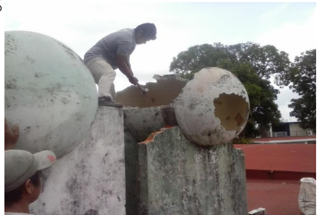
DEMOLICION DE TINACOS DE ASBESTO Y COLOCCION DE TINACOS ROTOPLAS TRICAPA DE 1100 LTS. EN AREA DE AZOTEA FINAL
